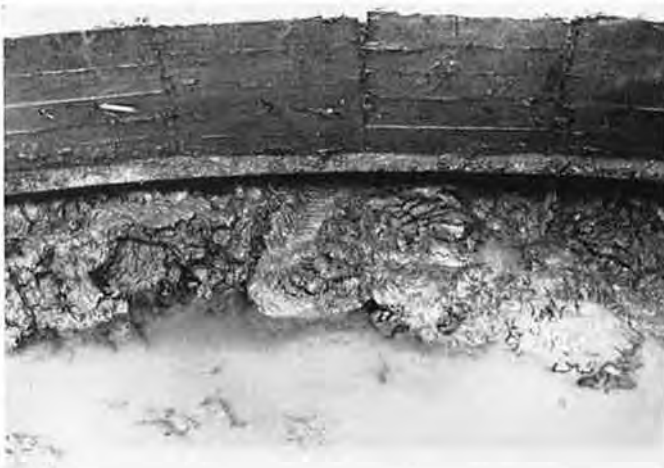
Abb. 64 Baugrube Pfeiler III. Grundbrucherscheinungen im sehr mageren, sandigen Moränenlehm an der Topfschneide bei offener Wasserhaltung.
